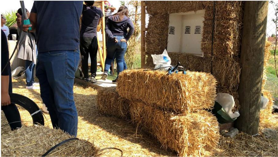
Figura 2. Taller de bioconstrucción en San Andrés Cholula Puebla, abril 2019, el muro está adosado a una estructura de postes reciclados y reutiliza elementos de madera para lograr espacios de almacenamiento. Foto Jaime J. Ríos Calleja.
