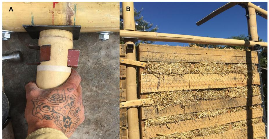
Figura 3a y 3b. Uniones de bambú a base de perfiles cuadrados PTR para la mejor resistencia a esfuerzos cortantes longitudinales, imagen tomada durante la construcción de vivienda emergente Iniciativa OCH8.2-BUAP, foto tomada por Jaime Ríos Calleja.
