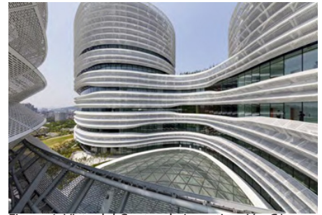
Figura 1. Vista del Centro de Investigación CJ
