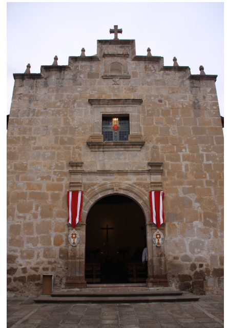
Figura 31. Acceso a Excapilla de visita Agustina, 15 agosto de 2015, SMG, Tomada por: Yolanda Cham Yuen
