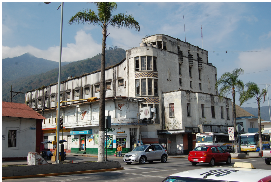
Figura 6. Aspecto actual del Teatro Río Blanco. Nota. El teatro Río Blanco dio servicio por casi sesenta años. Actualmente, como muchos cines, construidos en la época del cine de oro, perdió funciones en la década de 1990 y se encuentra en estado ruinoso. Imagen Edgar Pérez 2021.
