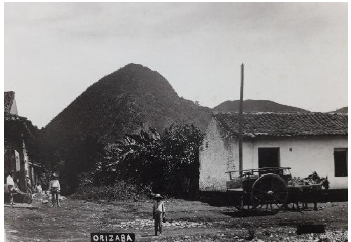
Figura 6. Vista de la vivienda vernácula a la entrada de la demarcación de la ciudad a principios de siglo XX, fuera del decretado Centro Histórico de Orizaba Ver. Fuente C.B. Waite ca. 1906 col. Fototeca INAH.
