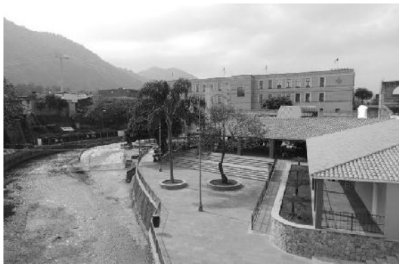
Figura 36. Vista del Río Orizaba y la construcción para acceso al teleférico desde el puente de la Avenida Poniente 5, dentro del perímetro del Centro Histórico de Orizaba Ver. Imagen de autor.
