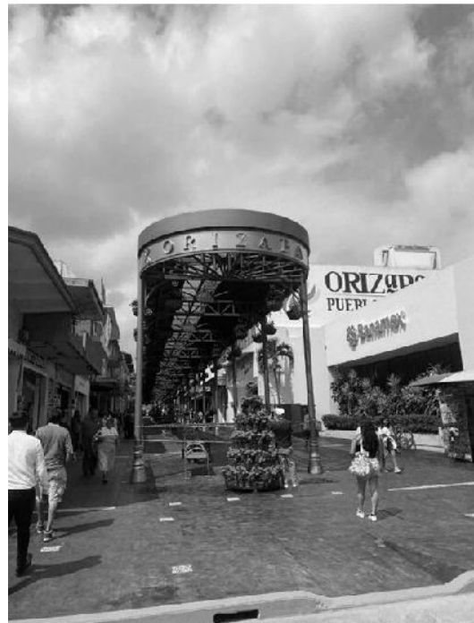
Figura 25. Vista de la Calle Fco. I. Madero donde se interviene con cobertizo en 2025 el área peatonal vista desde Avenida Oriente 2, dentro del perímetro del Centro Histórico de Orizaba Ver. Imagen de autor.
