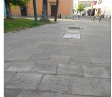
Figura 4: Pisos dispares y tapas levantadas.
