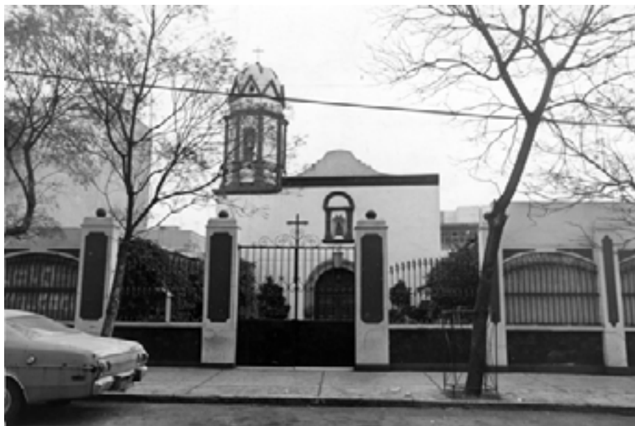
Fachada principal del Templo de Santo Tomás de Aquino. Fuente: Centro de Información del Patrimonio de la CDMX.
