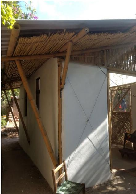
Figura 4. Prototipo de vivienda a base de estructura de bambú y paneles de tarimas de confinamiento rellenas de material residual recubiertas elaboradas por la Iniciativa OCH8.2-BUAP, foto tomada por Jaime Rios Calleja.
