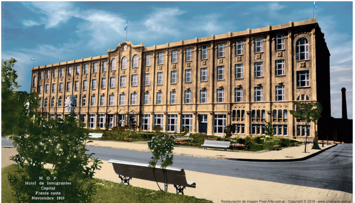
Hotel de los Inmigrantes, ciudad de Buenos Aires. Construcción 1906-1911. Foto de 1910 restaurada.
