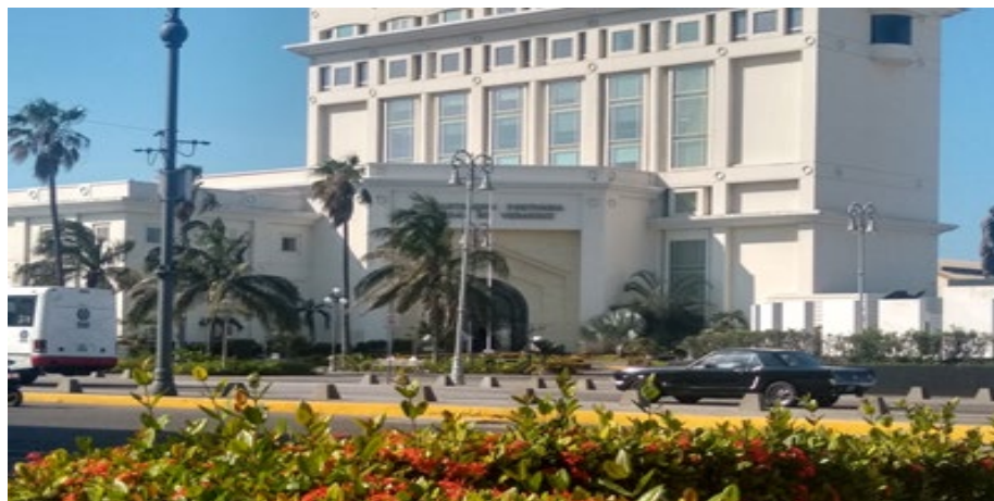
Figura 2. Edificio de la Administración Portuaria Integral o API (construido en 1974; modificado). Fotografía de Domingo Javier Quiroz Terán (Julio de 2020).
