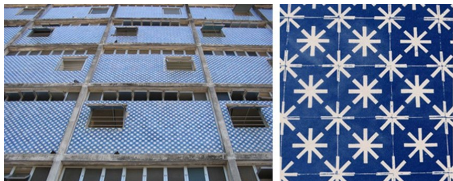
Figura 07. Uso del azulejo en fachadas. Edificio del IMIP. Fuente: Fotomontaje y fotos de Alcilia Afonso. 2004.
