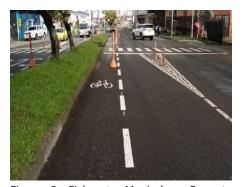
Figura 5. Ciclorruta Manizales= En esta imagen se demuestra que en algunos tramos de la ciclovía en Manizales dada a su perfil vial, causa embudos que obligan al vehículo del carril izquierdo invadir la ciclovía (Alzate, 2020).
