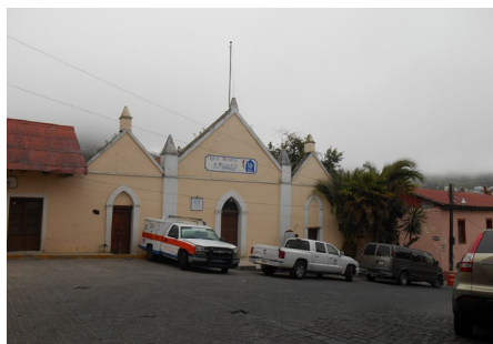
Figura 3. Iglesia Metodista, localizada a espaldas del templo católico (Benavides, M. 2017)
