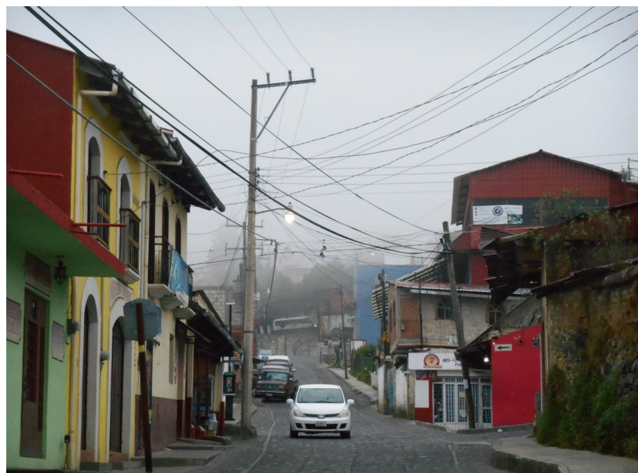
Figura 10. Alambrado aéreo con apariencia de telarañas (Benavides, M. 2017)
