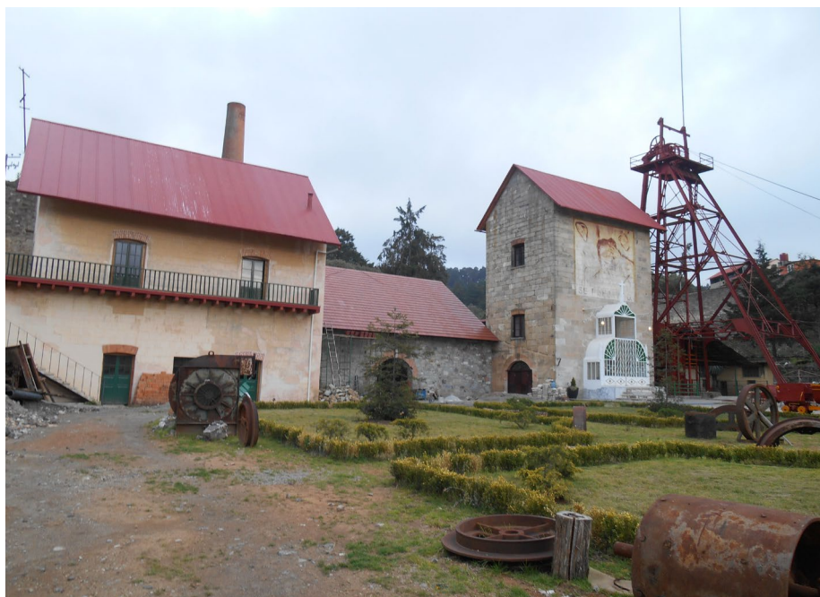
Figura 5. Mina clausurada, en proceso de adecuación como nuevo museo (Benavides, M. 2017)
